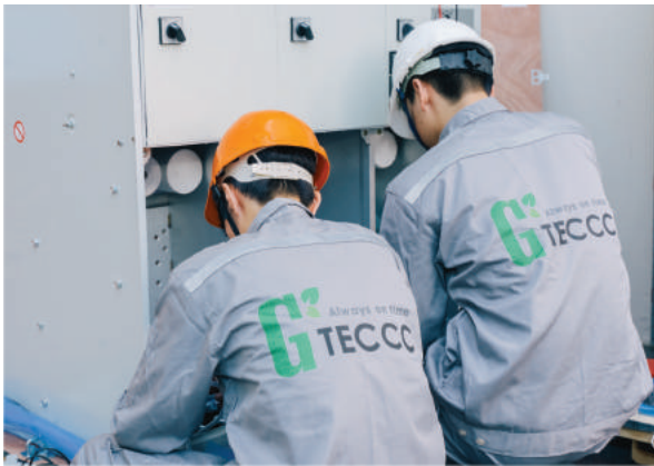
Lắp ghép tủ trung thế và cấu hình SCADA Assembling RMU and configuring SCADA
